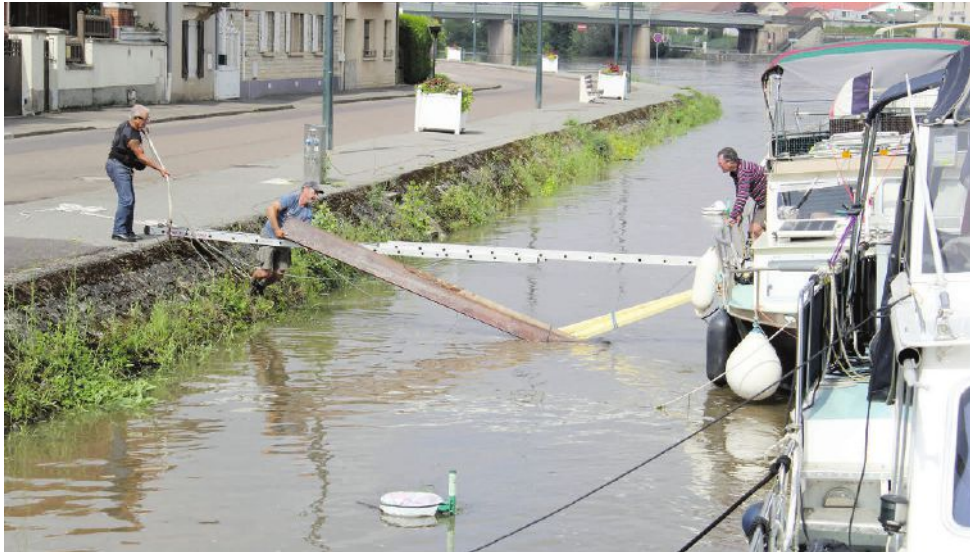
L'installation des planches avec le soutien de Jean-Christophe Voilly.
